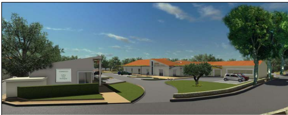
Vue depuis le rond point de la RD14
